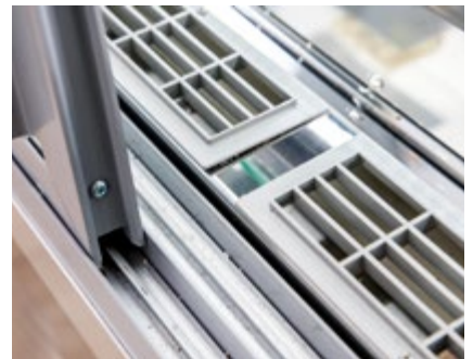
Laufschiene der Schiebetür und Luftführungsgitter
