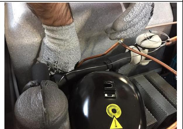
7. Den Kunststoffschutz der Kabel entfernen.
