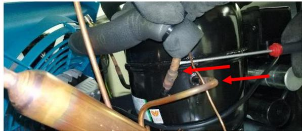
5. Den Verdichter entfernen, dazu an den entsprechenden Verankerungssystemen arbeiten.
