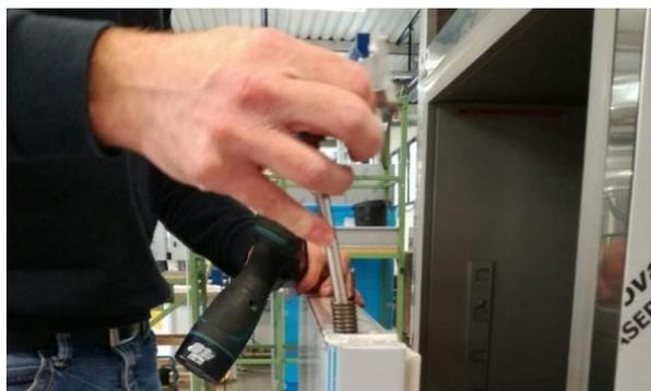
7. Die rechte Feder gegen die linke Feder austauschen, die durch den Verlauf der Spirale gegen den Uhrzeigersinn erkennbar ist, und diese in das Scharnier einsetzen.
