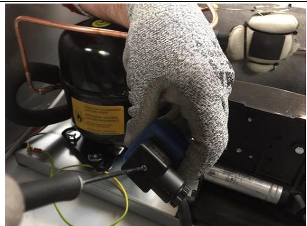
**7. Die Leitungen entlöten und das Ventil ersetzen.**
