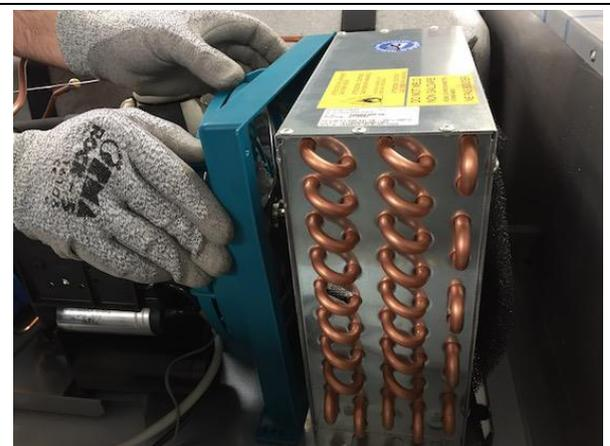
7. Die Befestigungsschraube des Gebläses und die vier Befestigungsschrauben des Gebläses am Förderer lösen.
